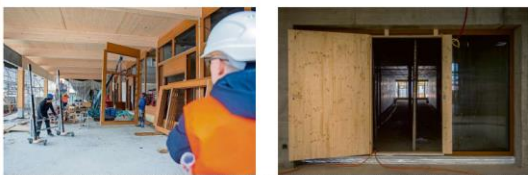
Es geht vor: Auch wenn noch in der neuen Dreifachhalle Fortuna (links) als auch in den Gängen der neuen Primarschule an der Ringstrasse (oben rechts) die Farbe grau noch dominiert, lässt sich bereits erahnen, wie und wo rund 600 Schülerinnen und Schüler ihre Schulzeit künftig verbringen werden. Auch der Tunnel unterhalb der Ringstrasse zum Schulhaus Herold ist bereits vorhanden (weiltes Bild unten links). Die Verantwortlichen der Stadt Chur: Dominique Felder (Lederhosen/Direktionsleiter) ad interim, Stadträtin Sandra Maisen, Gabriela Jäger-Waldler und Daniel Steink (beide Projektleitung Hochbau, Aufzählung von links sind zueinander mit dem Baufortschritt).
